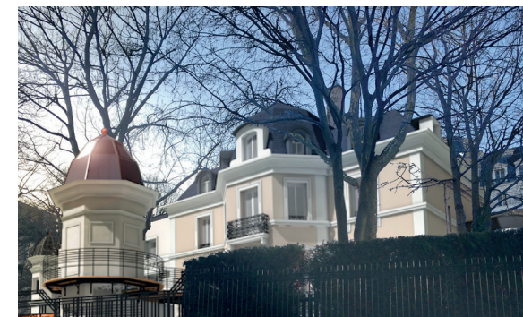
Extension de la crèche des Cèdres
