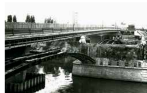
Travaux de construction du Pont de Puteaux, 1978, 3Fi109, AMP.
