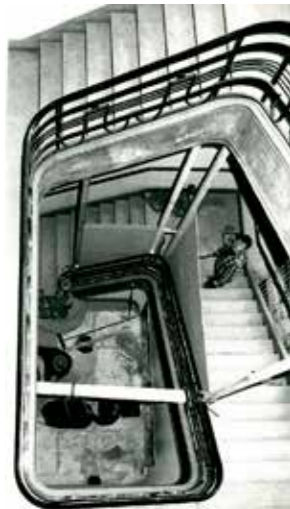
Travaux d'installation d'un ascenseur dans l'Hôtel de Ville, années 1970, 3Fi97, AMP.
