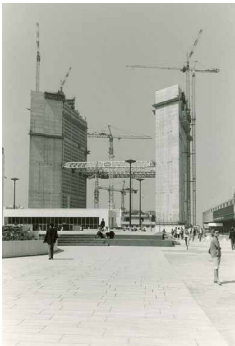
Travaux de construction de l'Arche de La Défense, années 1980, 3Fi107, AMP.
