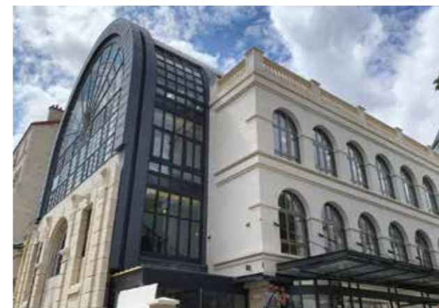
Rénovation de l'École Parmentier en 2021
