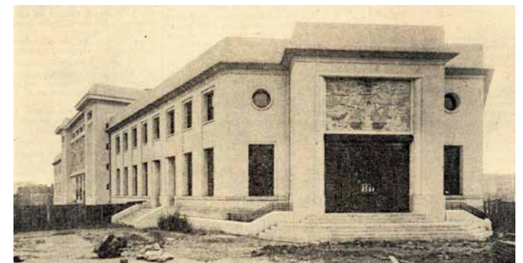
Photographies du chantier de l'Hôtel de Ville, tirées des bulletins municipaux de 1933-1934, 1PER/1, AMP.
