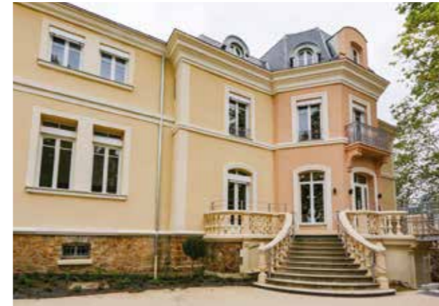
Rénovation de la crèche des Cèdres en 2021
