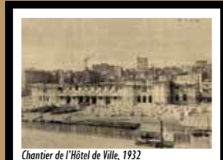
Chantier de l'Hôtel de Ville, 1932
