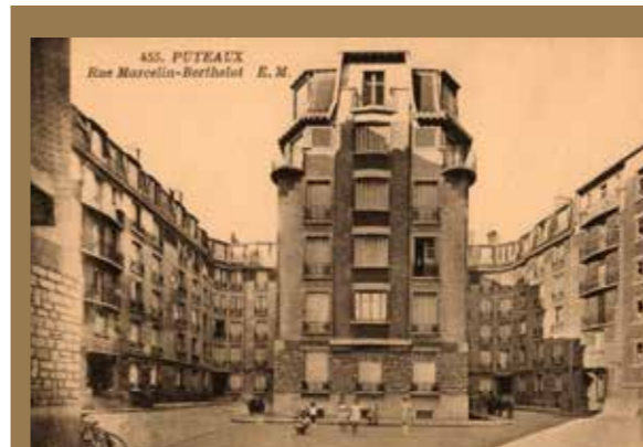
La cour intérieure de la résidence Marcelin Berthelot, 2Fi455, AMP
