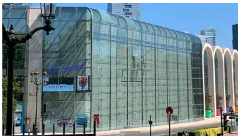
Le cinéma Le Central, 2009, service Communication.
