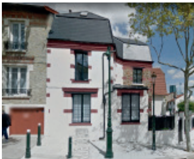
Bâtiment intégré dans son environnement proche
