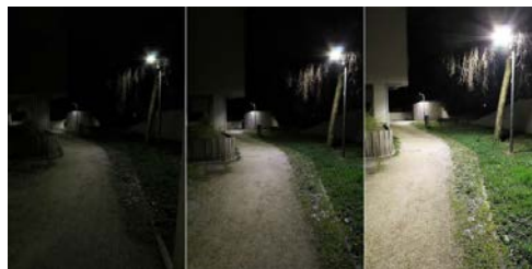
Exemple de variation d'intensité lumineuse (©Ville de Crolles)
