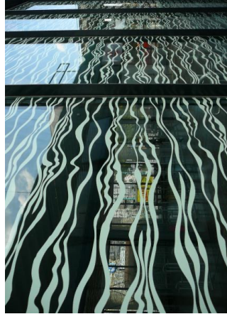
Exemple de vitre limitant les collisions pour l'avifaune (©Batirama)
