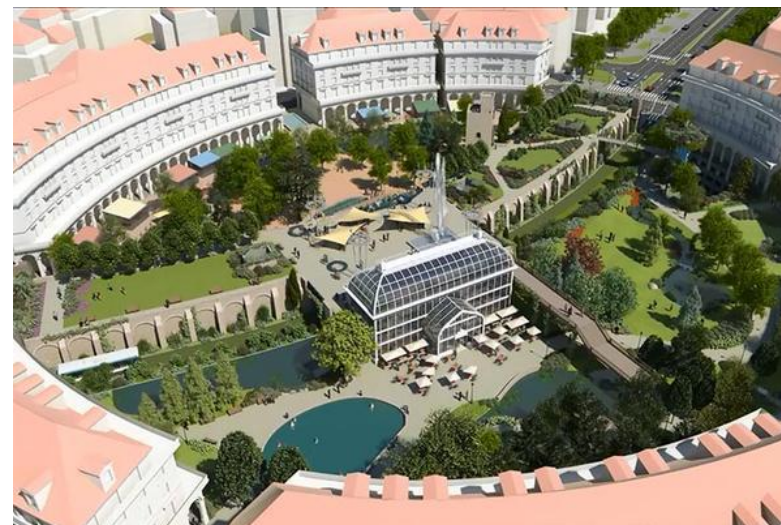
Couverture de la RD 913 dans l'EcoQuartier des Bergères
