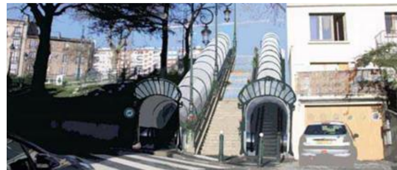
Escalators rue Monge
