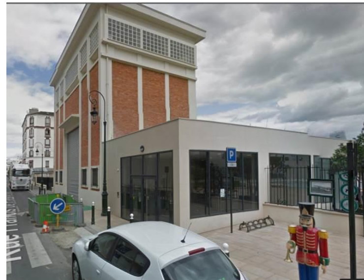
Centrale électrique 6 rue Pressensé
