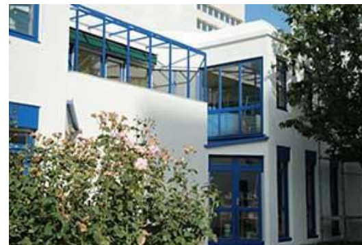
Crèche municipale des Deux Coupoles
