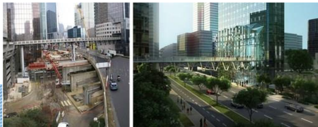
La Défense, travaux en cours en bordure du boulevard Circulaire (Atlas des paysages et des projets urbains des Hauts-de-Seine)
