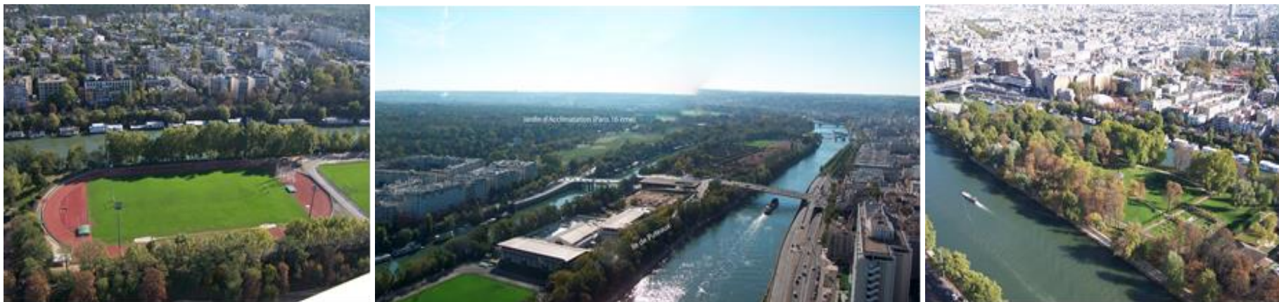
Vues aériennes sur l'île de Puteaux (Source : Ville de Puteaux, PLU 2014)
