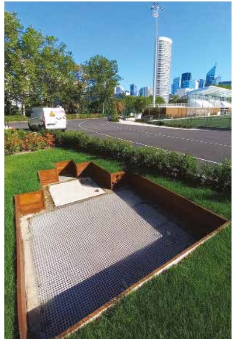
Regard technique de la cuve de récupération des eaux pluviales sur l'île de Puteaux
