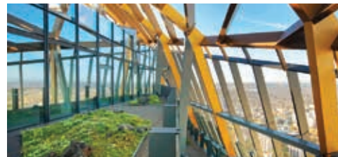
Au-delà de ses 650 m 2 de toiture, végétalisée à 50 %, sous une coiffe métallique de 20 mètres de haut, la tour accueille plus de 2 500 m 2 d'espaces extérieurs accessibles
