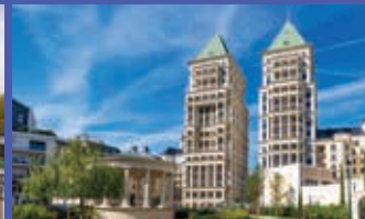
Résidence Ouest Village
