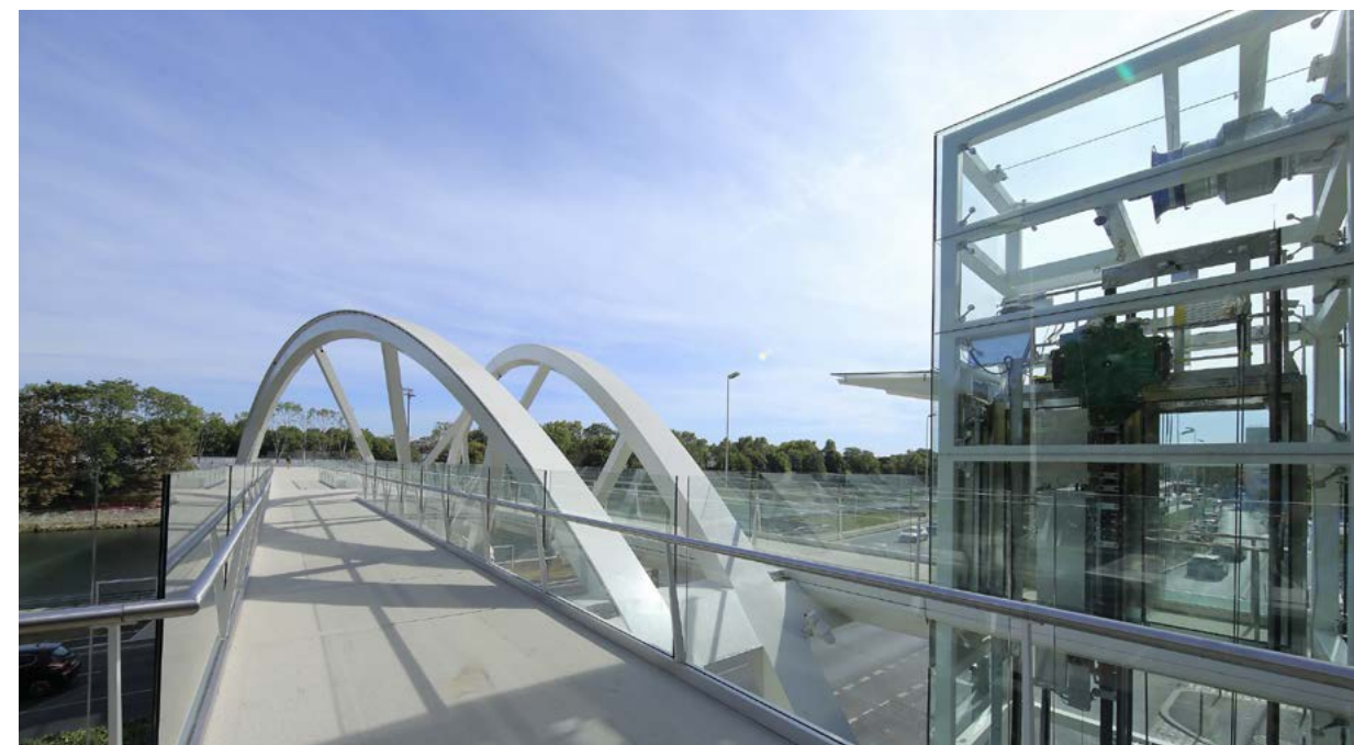
L'ascenseur de la passerelle Coty
