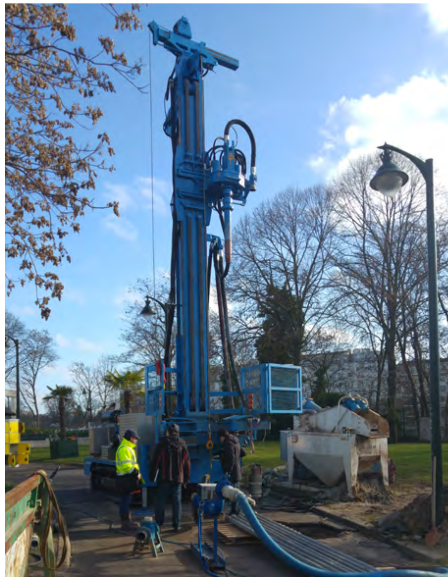
Forage de la géothermie au Palais des Sports
