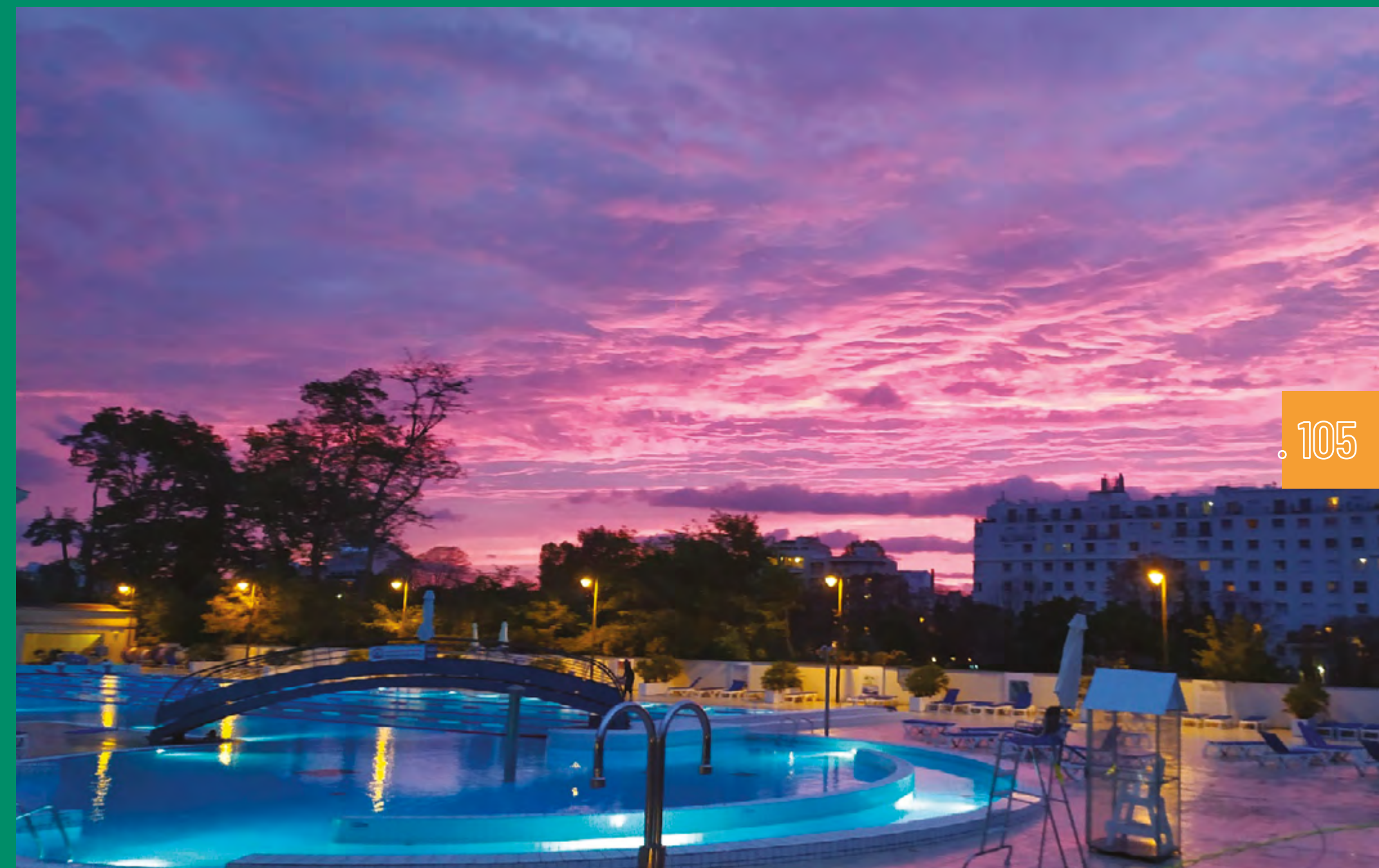
La piscine du Palais des Sports dispose d'une unité de géothermie pour limiter l'utilisation des pompes à chaleur. Elle est aussi dotée d'un volet de protection pour limiter les déperditions
