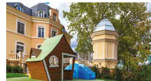
Crèche des Cèdres Extension et réhabilitation complète
