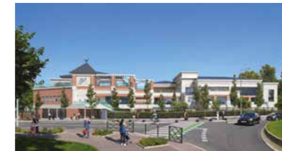
École Jean de La Fontaine Extension du site et rénovation globale de l'enveloppe extérieure du bâtiment
