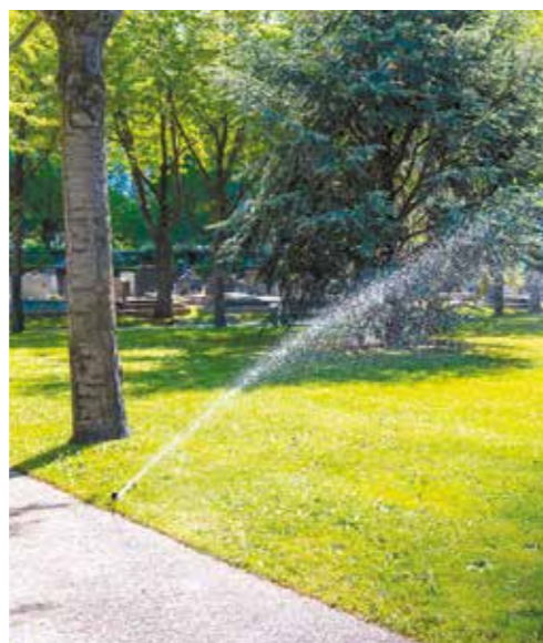
Arrosage automatique raisonné relié à une sonde de détection d'hygrométrie
