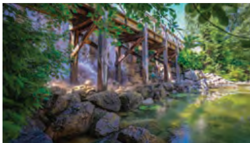
La cascade de l'ÉcoQuartier des Bergères
