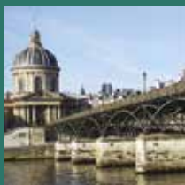
1 - Pont des Arts (1801-1804) Pont d'Austerlitz Pont d'Île
