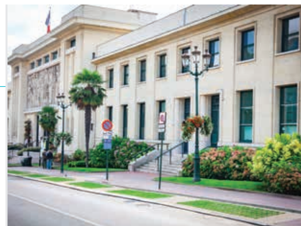
Les nouvelles places de stationnement engazonnées et perméables
