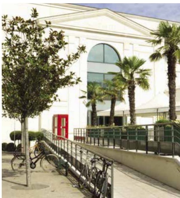
Accès pour les personnes à mobilité réduite au Palais des Sports
