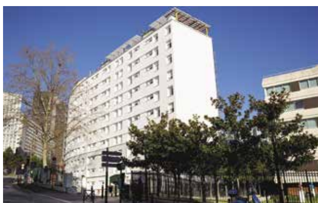
La résidence Anatole France après travaux
