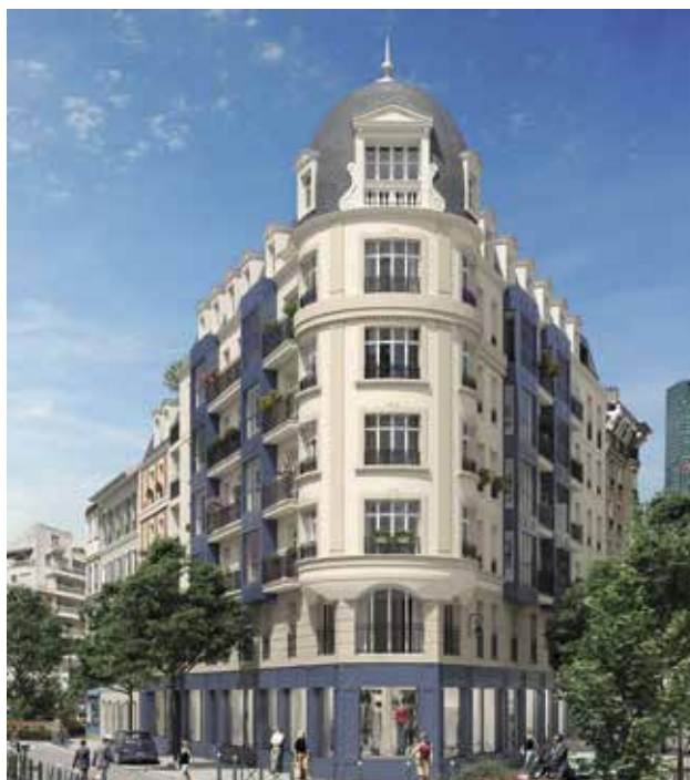
Future résidence Klepping, rue de l'Oasis
