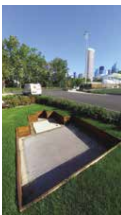
Cuve de récupération
