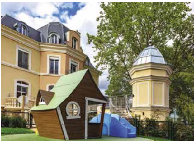
La Crèche des Cèdres rénovée
