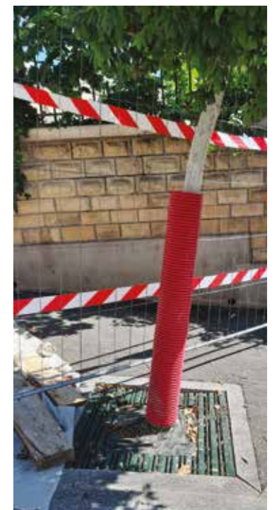
Arbre protégé pour un chantier
