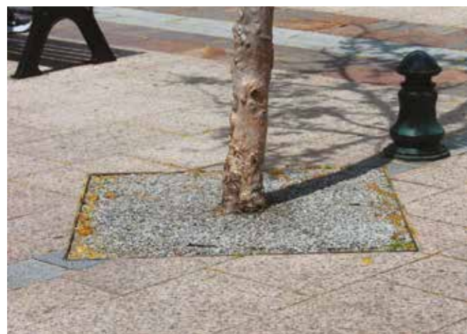
Un pied d'arbre imperméabilisé
