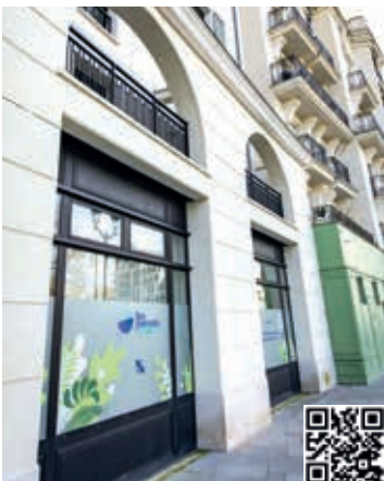
CRÈCHE MULTI-ACCUEILS LUCIEN 64 AVENUE DES BERGÈRES
