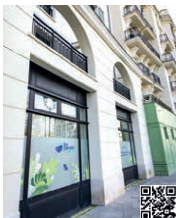
CRÈCHE MULTI-ACCUEILS LUCIEN 64 AVENUE DES BERGÈRES
